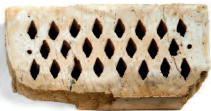
Gitterstein mit Frostschäden.
