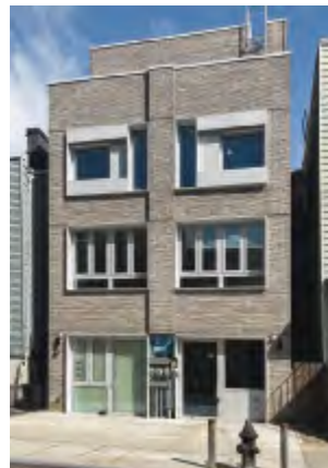
19 1030 Lorimer Street, Brooklyn Architekt: Schneider Associates Fertiggestellt: 2017 Ziegel: K91 Foto: Michael Sheridan
