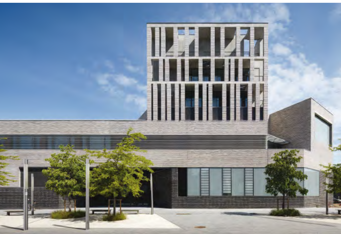
Der dunkelgraue Sockel mit Reliefmauerwerk verankert das Gebäude im Boden. Die horizontale Ausdehnung des Sockels wird durch lange Sonnenlamellen aus Aluminium unterstrichen. Darüber erheben sich – wie ein Turm aus Buchrücken – schlanke Ziegelsteinsäulen. Foto: Takuji Shimmura
